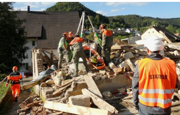
Du matériel de sauvetage est préparé. Au premier plan: les experts en statique conseillant désormais l'état-major cantonal de crise durant l'appréciation permanente de la situation en matière de décombres.
