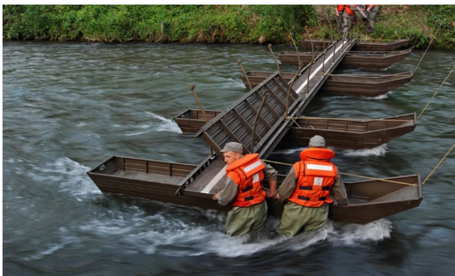
En 75 minutes, les pionniers ont mis en place et fixé deux passerelles, et assuré leur éclairage.
