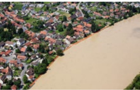
Le mur de protection orange à Wallbach.
