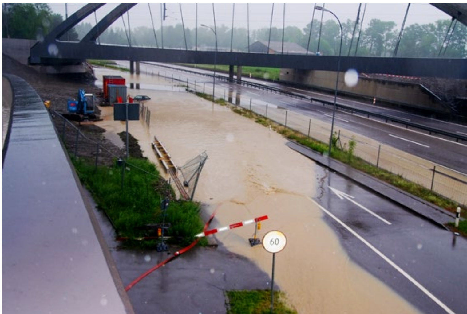
Souvent les inondations touchent également les infrastructures importantes – comme ici en juin 2013 dans la vallée du Rhin.
