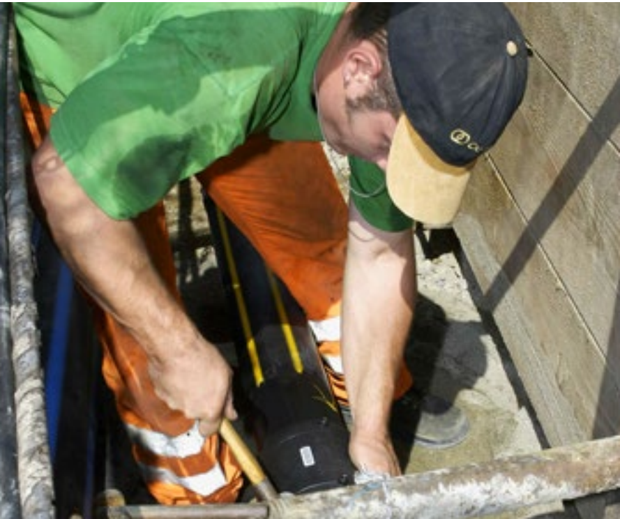
Pour les services techniques, l'entretien de l'infrastructure fait partie du quotidien. Cependant, ils doivent également être préparés aux cas de catastrophe et aux situations d'urgence.
