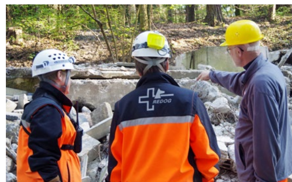
Des experts REDOG et un ingénieur lors de la reconnaissance sur les lieux du sinistre.
