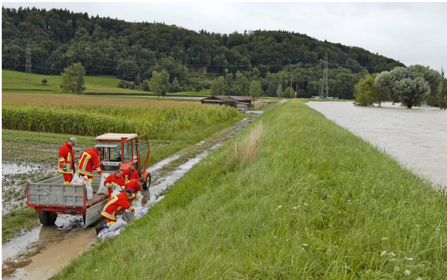
Un échange d'informations rapide entre les organes de conduite est essentiel, notamment lors de crues. A l'image: les crues de 2007 dans le canton de Berne.
